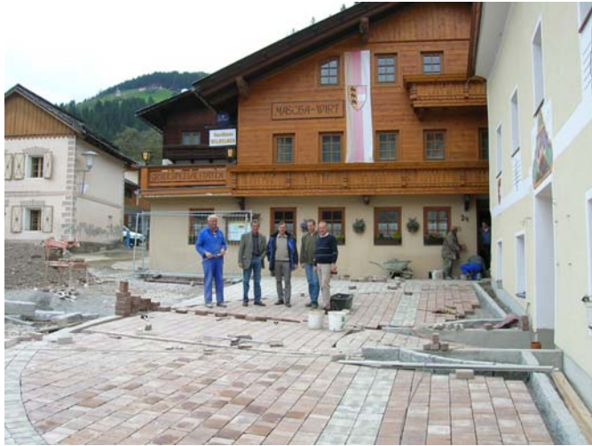
Der Gemeindevorstand bespricht sich mit den Anrainern und den Bauausführenden
