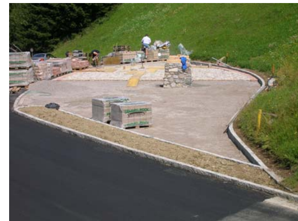
Die Pflasterung wurde aus Kostengründen in Eigenregie durchgeführt.
